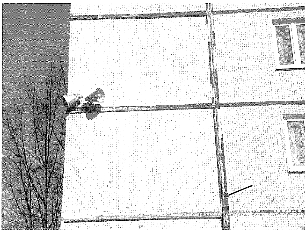
Рис. 3.2.8. Фрагмент стены по оси «8» в осях «А» - «Г». Разрушение заполнения шва между панелями в уровне 2-го этажа.
