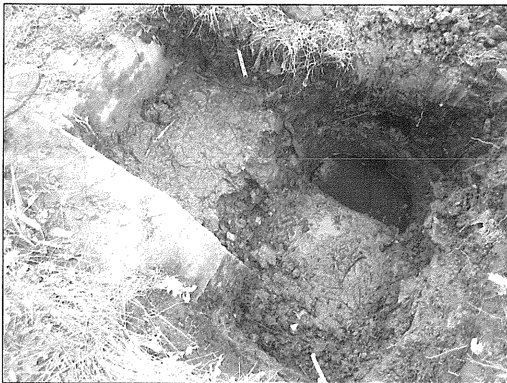
Вид на фундамент в шурфе Ш-2.
