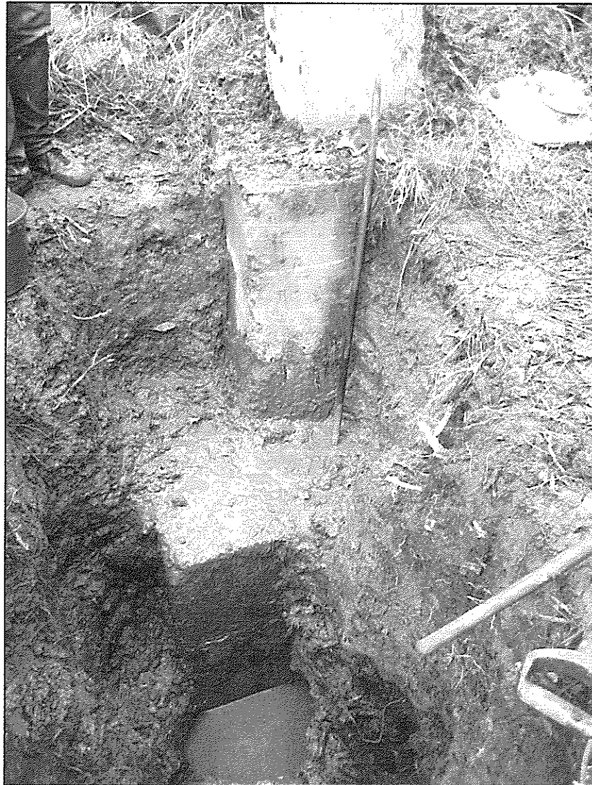
Вид на фундамент в шурфе Ш-4.
