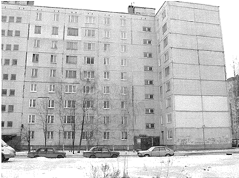
Рис. 4.1.2. Здание по адресу: ул. Чудновского, дом 6, корпус 1. Торцевая секция. Общий вид со стороны двора.
