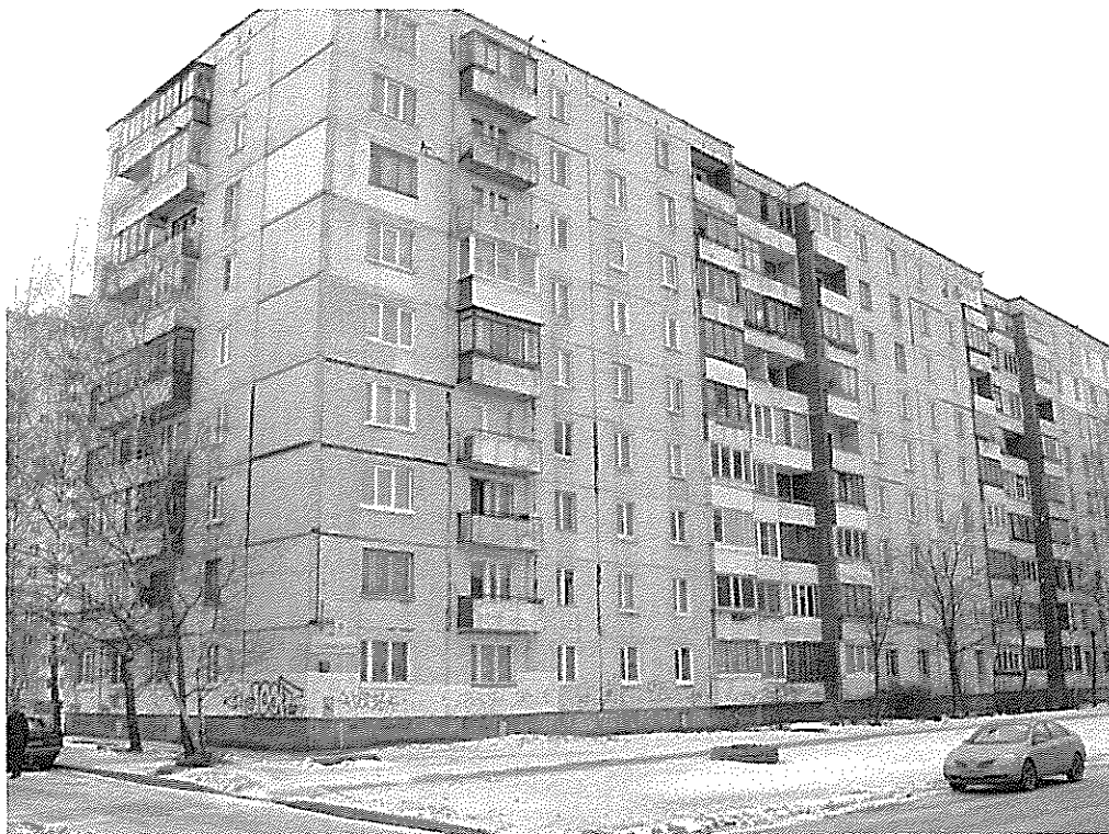
Рис. 4.1.1. Здание по адресу: ул. Чудновского, дом 6, корпус 1. Торцевая секция. Общий вид со стороны ул. Чудновского.
