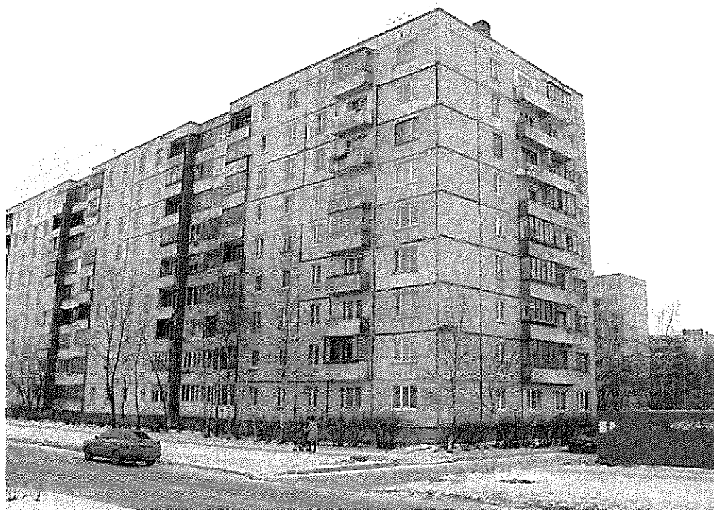
Рис. 3.1.1. Здание по адресу: ул. Чудновского, дом 2. Торцевая секция. Общий вид со стороны ул. Чудновского.
