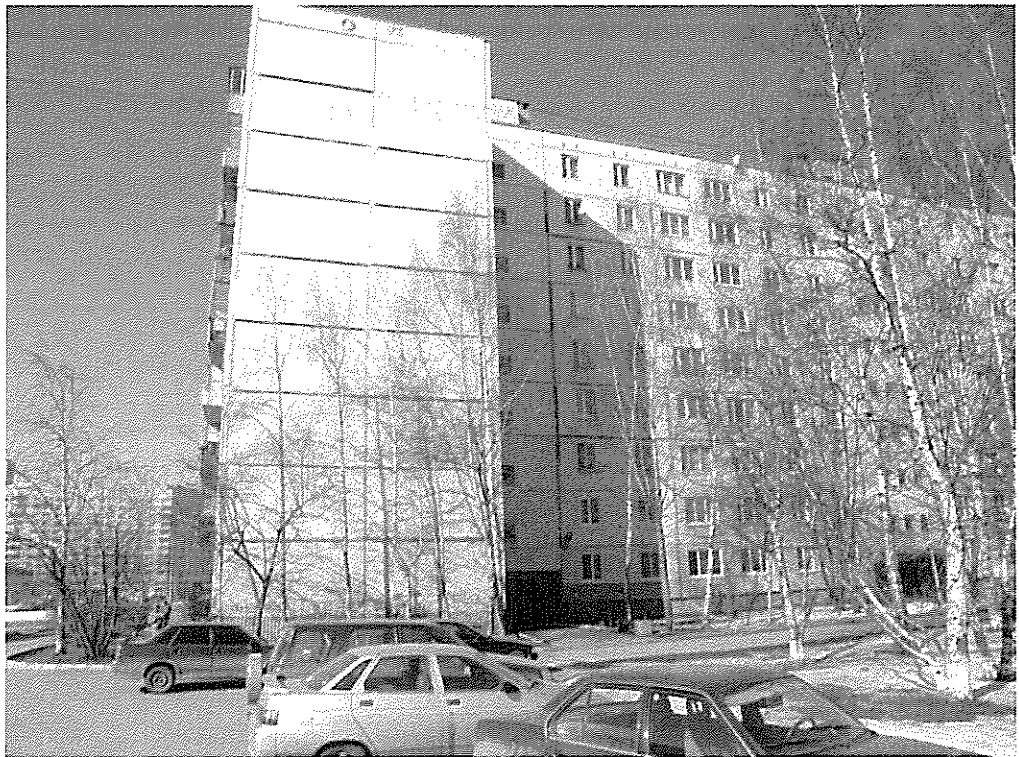
Рис. 3.1.2. Здание по адресу: ул. Чудновского, дом 2. Торцевая секция. Общий вид со стороны двора.
