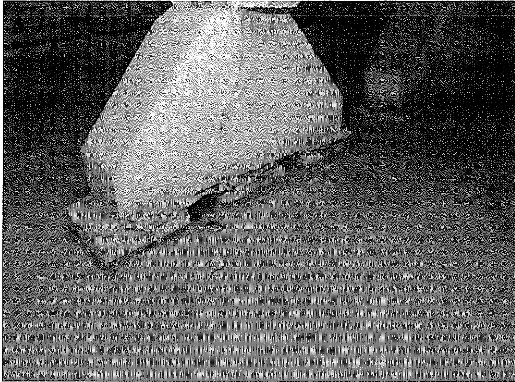
Рис. 4.2.10. Помещение подвала в осях «1» - «8» / «А» - «Д». Трапециевидный фундаментный блок, основанный на железобетонных оголовках свай.
