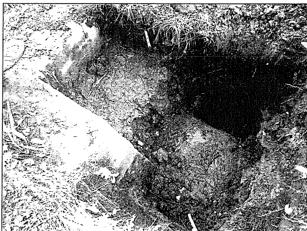
Вид на фундамент в шурфе Ш-2.
