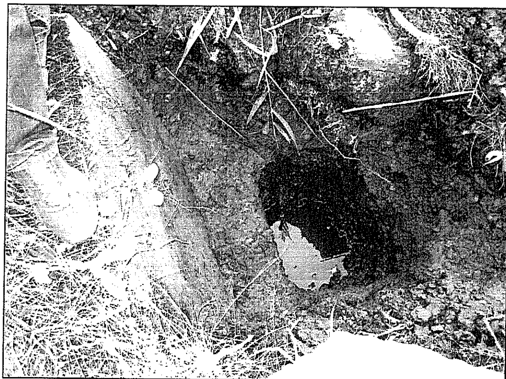
Вид на фундамент в шурфе Ш-3.
