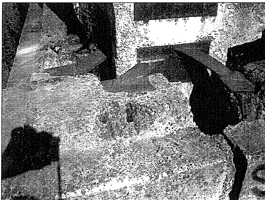
Фрагмент крепления стеновых панелей к колонне.
