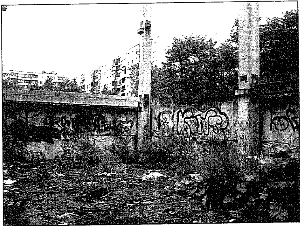
Вид на элементы каркаса в осях «Л-М» м/о «3-4».
